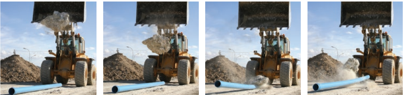
Secuencia real fotográfica en obra.
