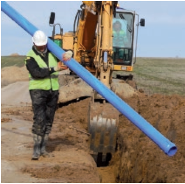
La tubería PVC-O es extremadamente ligera.
